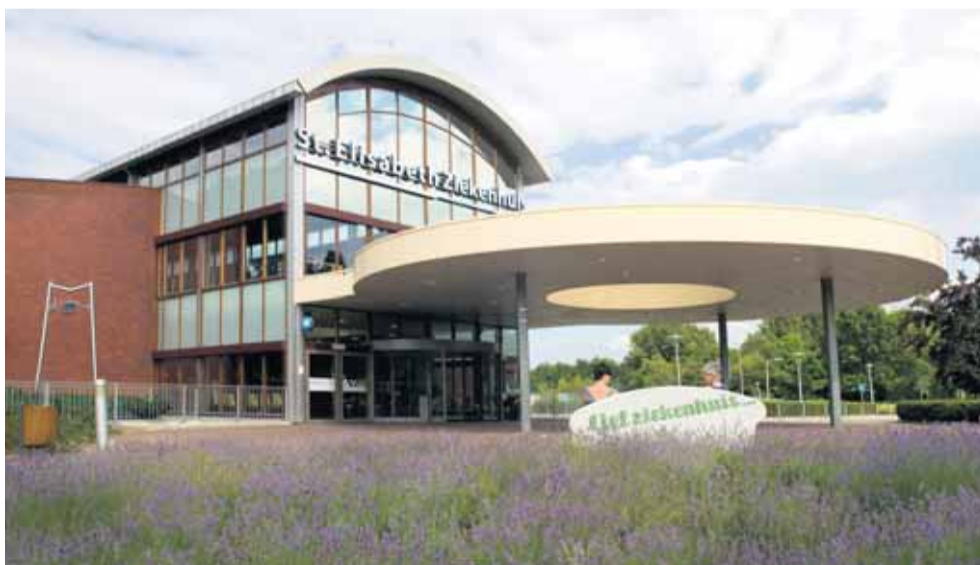
De locatie St. Elisabeth Ziekenhuis aan de Hilvarenbeekseweg in Tilburg zet de expertise van Hoppenbrouwers Elektrotechniek BV in voor het ontwerpen en vervangen van de oude brandmeldinstallatie.
